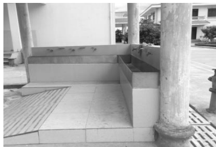
＜完成した手洗い場＞
